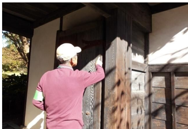
図 94 文化財パトロール員の巡視
