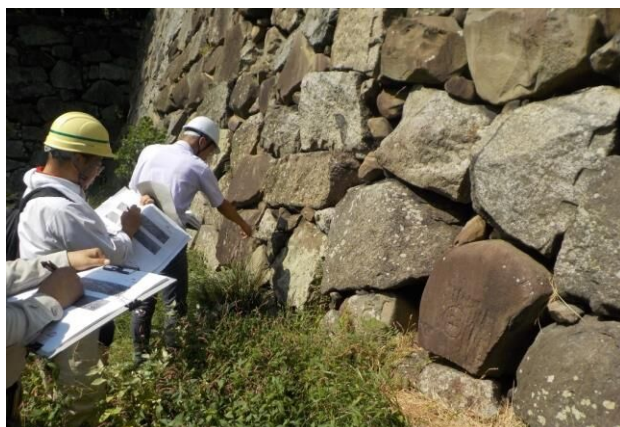
図 89 名古屋城跡石垣の調査
