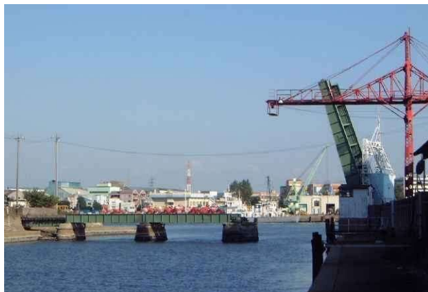
図 118 名古屋港跳上橋
