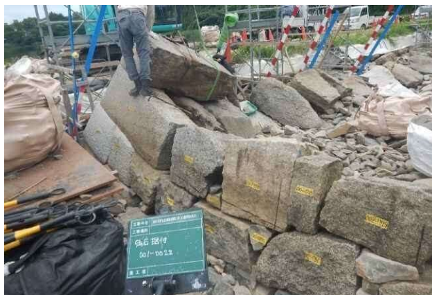
図 90 名古屋城石垣の整備
