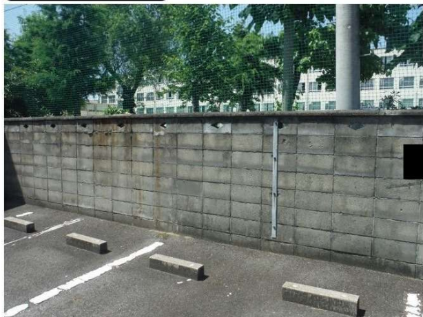
老朽化したコンクリートブロック塀
