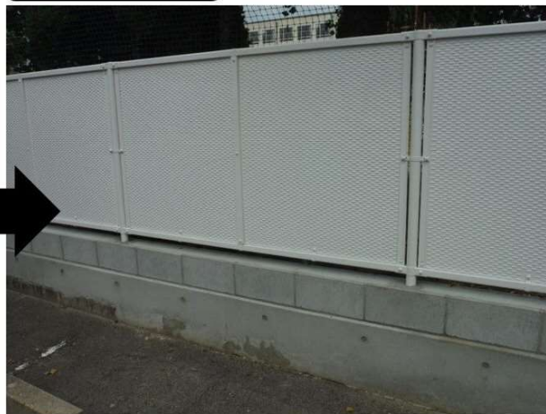
コンクリートブロック塀を撤去し、 目隠しフェンスを設置
