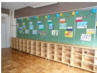
○教室の可動間仕切りと可動ロッカー
