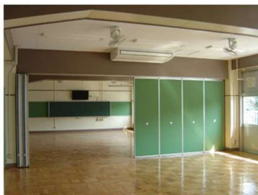
■可動間仕切りの設置
