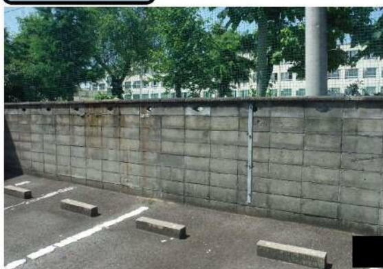
老朽化したコンクリートブロック塀
