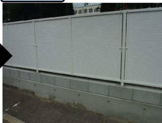
コンクリートブロック塀を撤去し、目隠しフェンスを設置
