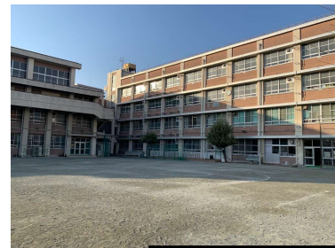
校舎棟・体育館棟
