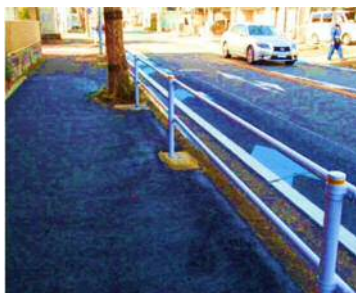
狭い歩道にガードパイプを設置
