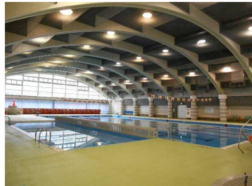
【屋内温水プール】
