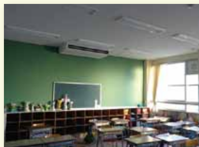
普通教室への空調設備の整備
