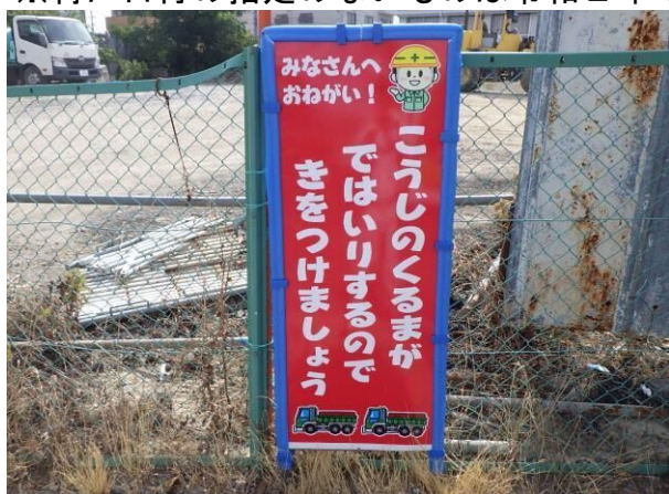
資材置場出入口に子供達への注意看板設置
