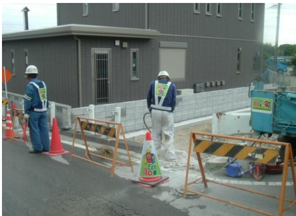
「こども110番の工事現場」写真は、H24年6月28日。
