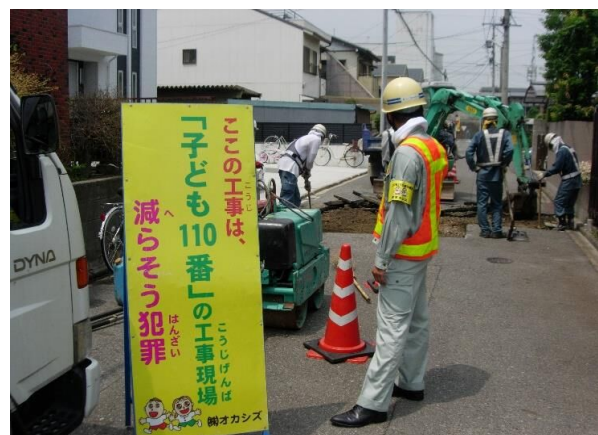
25/7 施工現場の地域の子供たちを守る
