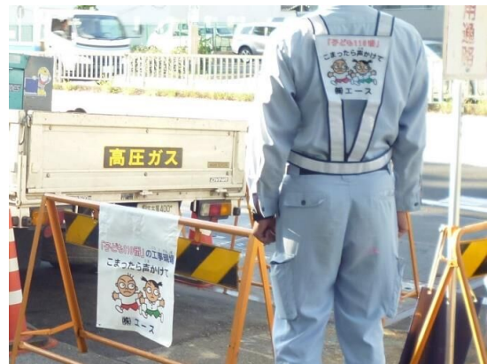
子どもに優しい工事現場
