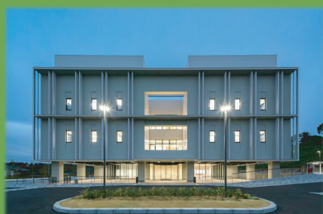
研究所棟外観-西面（夜景）
