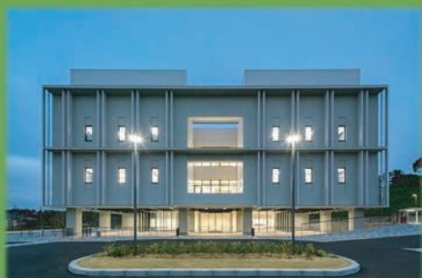
研究所棟外観-西面（夜景）
