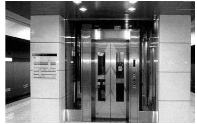
地下鉄駅エレベーターの整備
