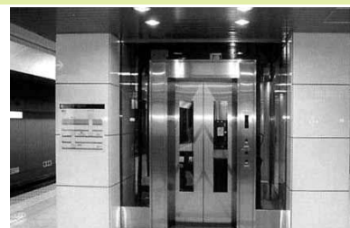
地下鉄駅エレベーターの整備
