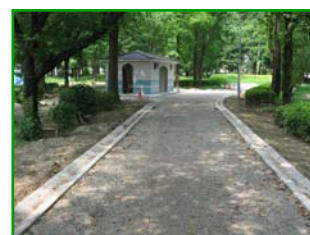
↑ 園路と広場の段差解消
