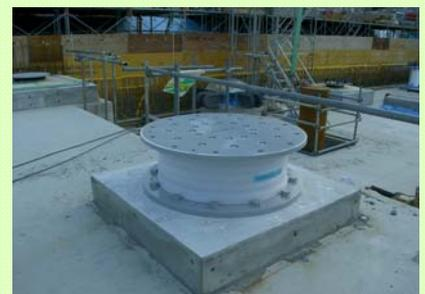
写真 免震装置(積層ゴム)設置状況
