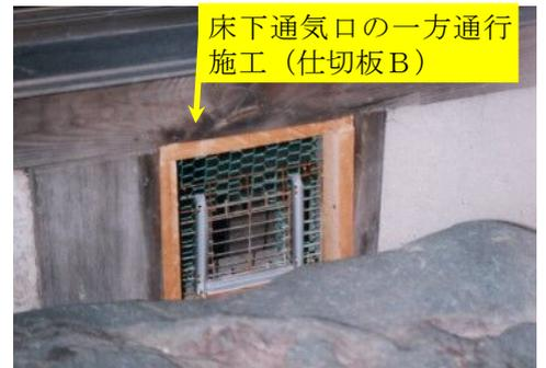
床下通気口の一方通行施工（仕切板B）
