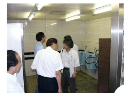
久屋大通駅トイレの検証
