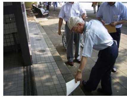
噴水南バスターミナルトイレ付近の段差を検証
