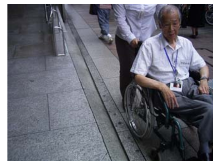
久屋大通西側歩道と民有地との段差を検証
