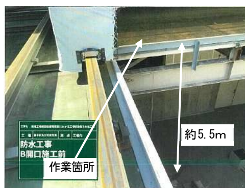
作業場所（高さ約5.5m）
