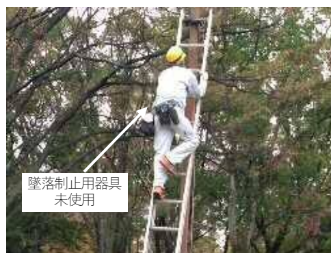
作業状況（拡大）
