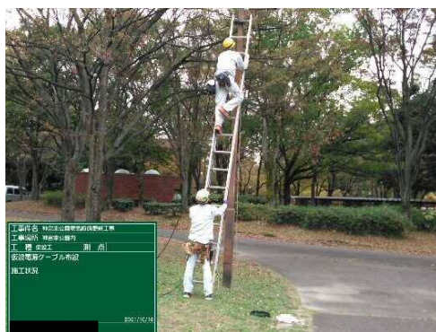
作業状況（高さ約3.5m）
