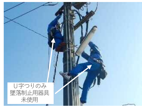
作業状況（拡大）
