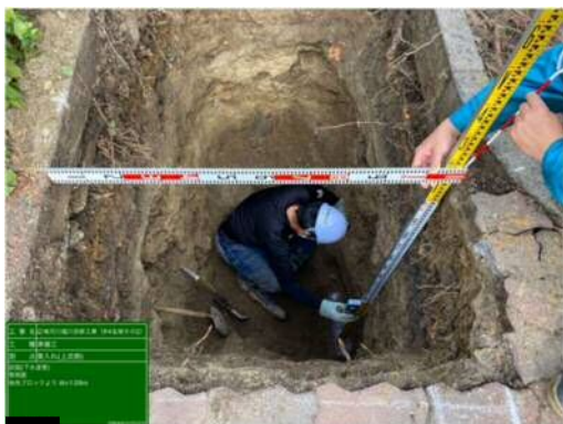
作業状況（深さ2.1m）
