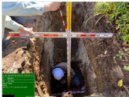
作業状況（深さ1.9m）
