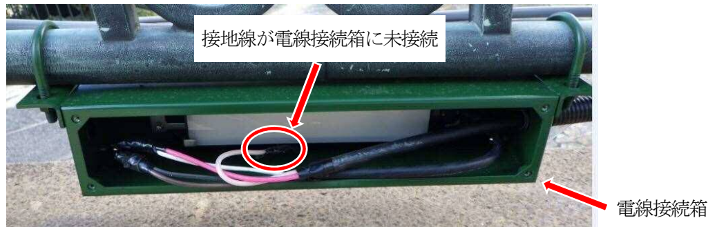
電線接続箱 (端部) の状況
