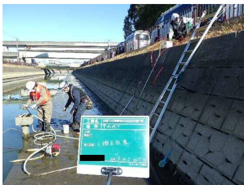
作業状況（河川側より撮影）
