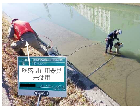
作業状況（高さ約2.3m）
