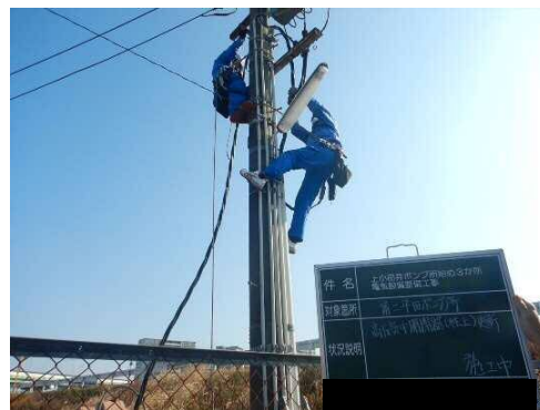
作業状況（高さ約5.0m）
