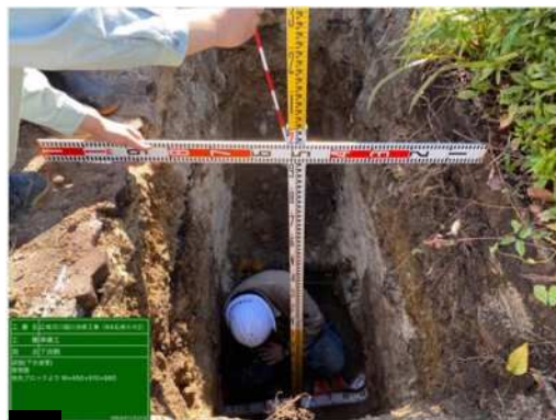
作業状況（深さ1.9m）
