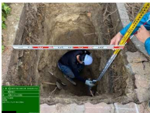
作業状況（深さ2.1m）
