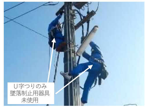
作業状況（拡大）
