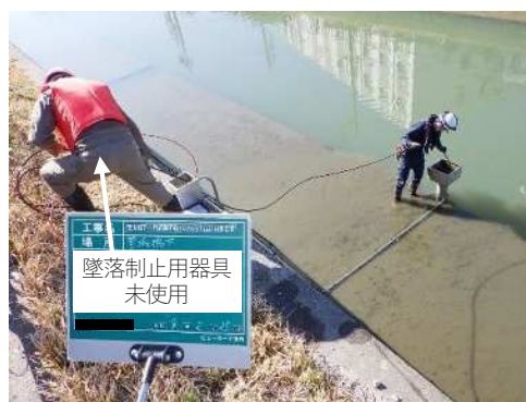
作業状況（高さ約2.3m）
