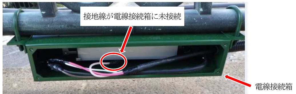
電線接続箱 (端部) の状況
