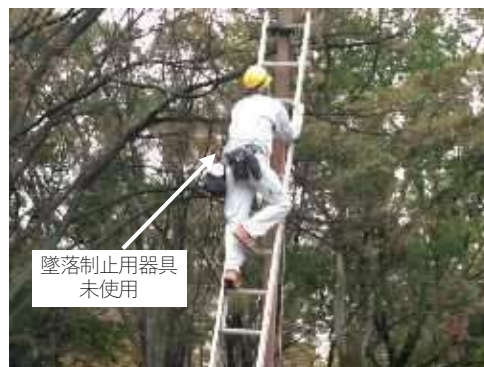
作業状況（拡大）
