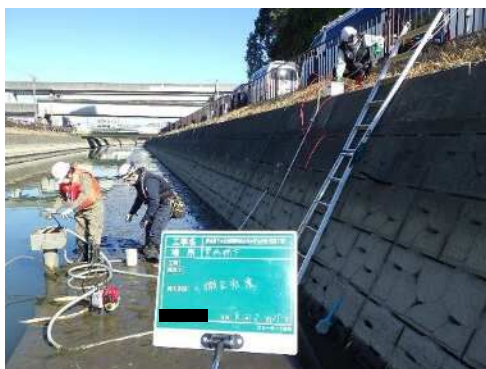
作業状況（河川側より撮影）
