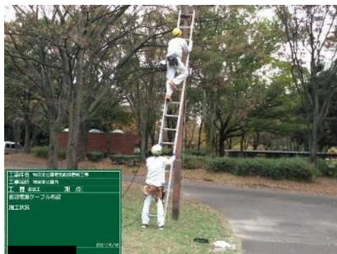
作業状況（高さ約3.5m）
