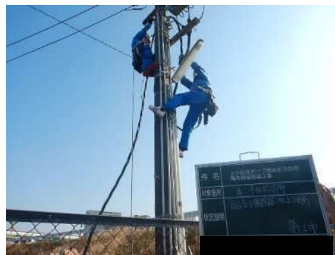
作業状況（高さ約 5.0m）
