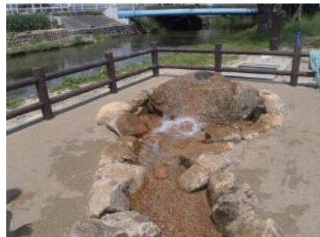
浅層地下水を堀川に導水 (守山区 瀬古橋付近)
