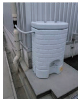
雨水タンクの設置
