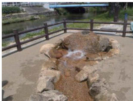
浅層地下水を堀川に導水 (守山区 瀬古橋付近)
