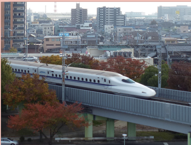
新幹線の防音壁 (熱田区二番二丁目)
