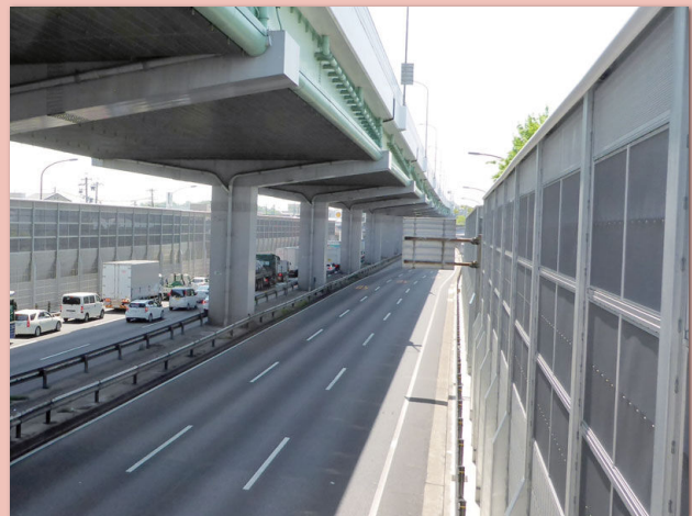
道路の防音壁 (南区要町)
