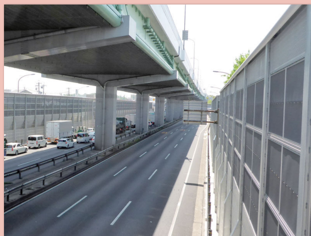
道路の防音壁 (南区要町)
