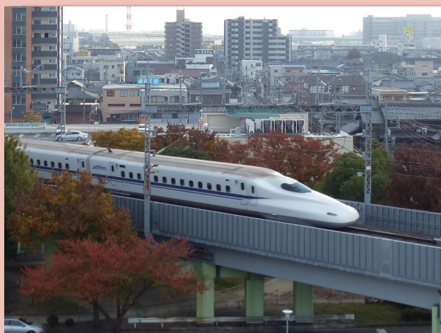
新幹線の防音壁 (熱田区二番二丁目)
