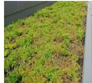
セダムによる屋上緑化の例
