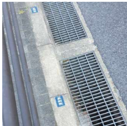
雨水浸透ます
