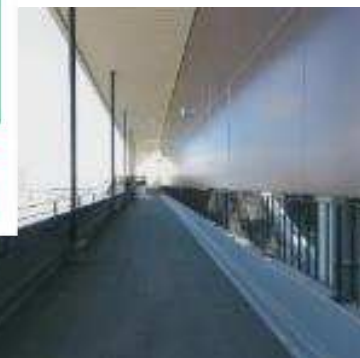
津波避難スペースの設置
