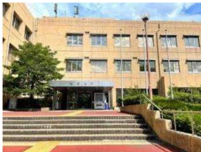
港区役所への停電災害時の電源供給
