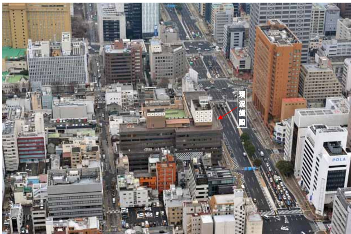
写真 2-5-1 事業予定地及びその周辺の状況（撮影日：平成 24 年 1 月／中日新聞社提供）
