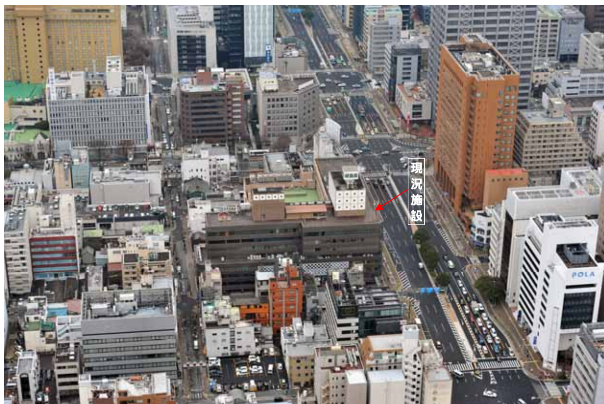
写真 2-12-1 事業予定地及びその周辺の状況（撮影日：平成 24 年 1 月／中日新聞社提供）
