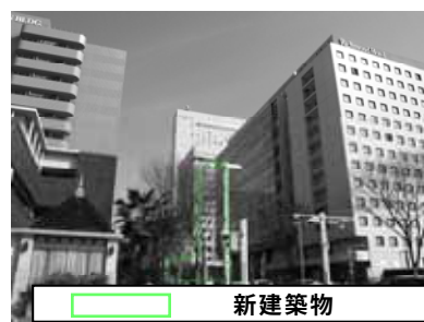
写真 2-5-6 No.5 地点（納屋橋・旧加藤商会ビル前、撮影日：平成 25 年 2 月 26 日）
