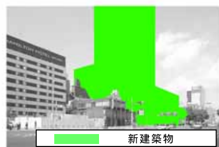
写真 2-5-3 No.2 地点（三蔵交差点、撮影日：平成 25 年 3 月 19 日）
