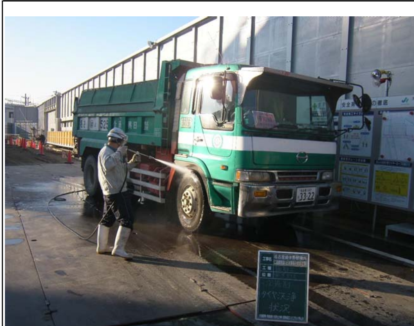
搬出入車両の洗浄実施状況
