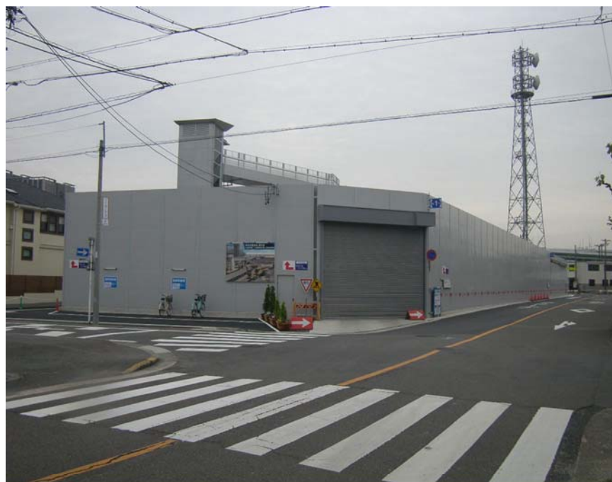
防音措置状況
