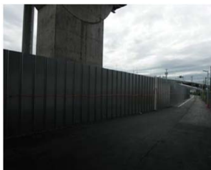
防音措置状況
