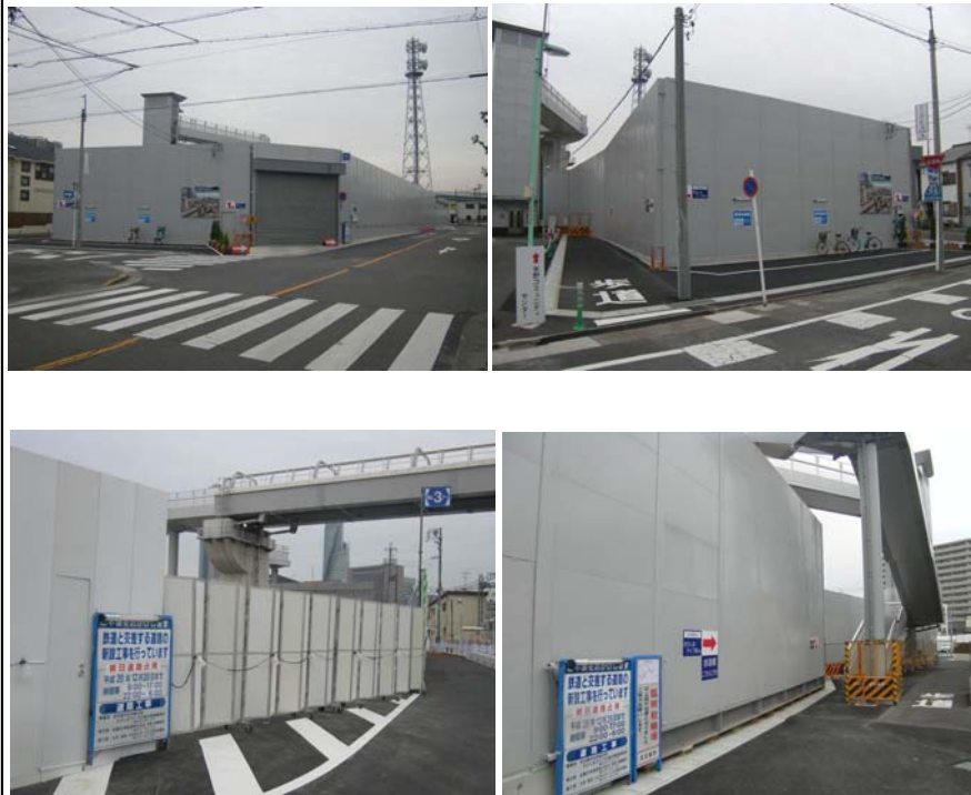
工事ヤード仮囲い 設置状況
