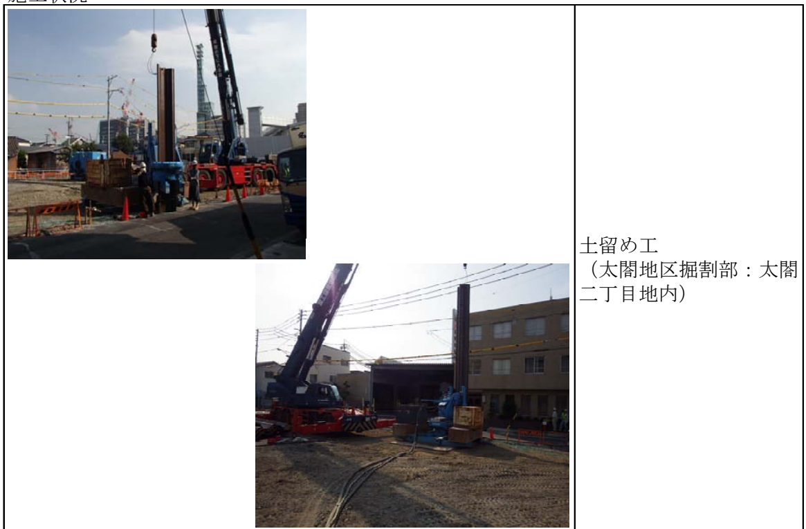
図 3-3(1) 騒音振動に係る環境保全措置（土留め工：太閤地区掘割部）
