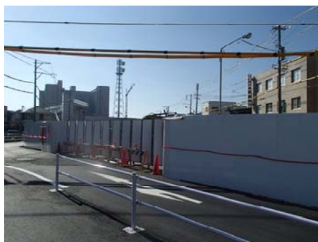
図 3-4(1) 騒音振動に係る環境保全措置（土工：太閤地区掘割部）
