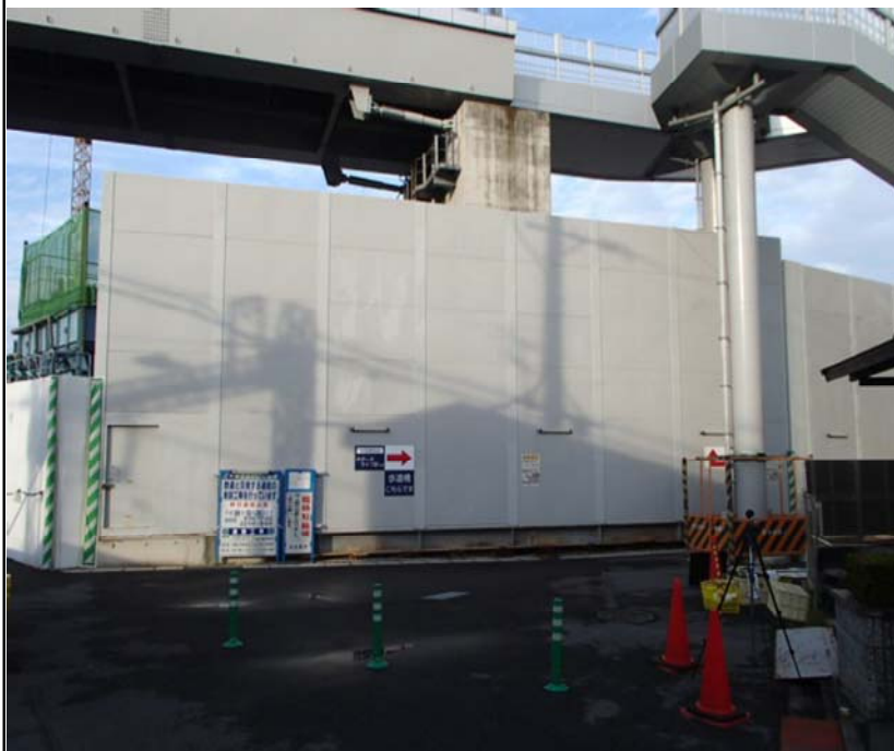
図 3-6(1) 騒音振動に係る環境保全措置（躯体工：ささしま地区アンダーパス部）
