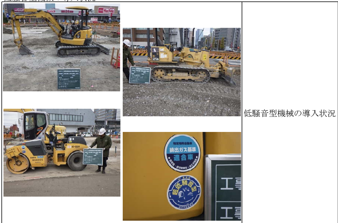
図 3-2(2) 騒音振動に係る環境保全措置（路盤工：太閤地区平面部） 施工状況
