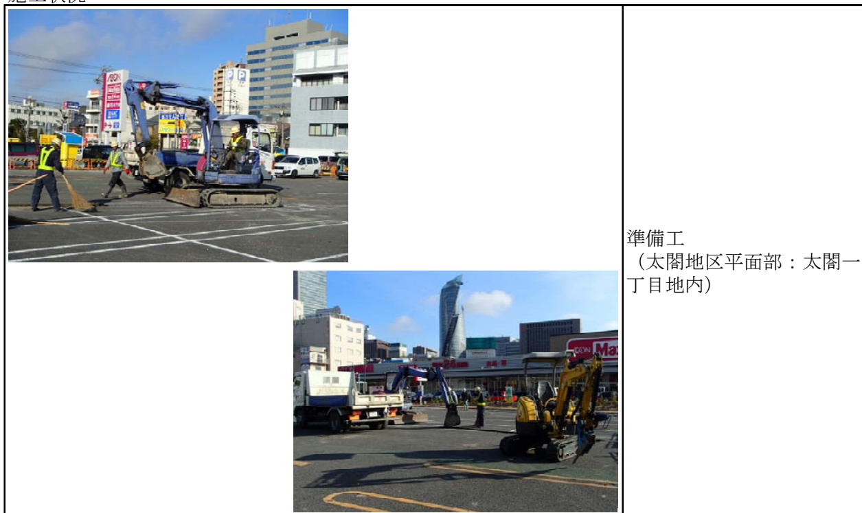
図 3-1 騒音振動に係る環境保全措置（準備工：太閤地区平面部）
