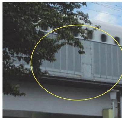
図4 防音壁の設置状況
