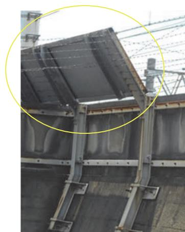
図6 防音壁の設置状況
