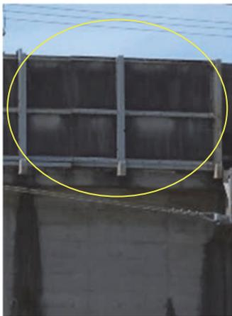
図1 防音壁の設置状況
