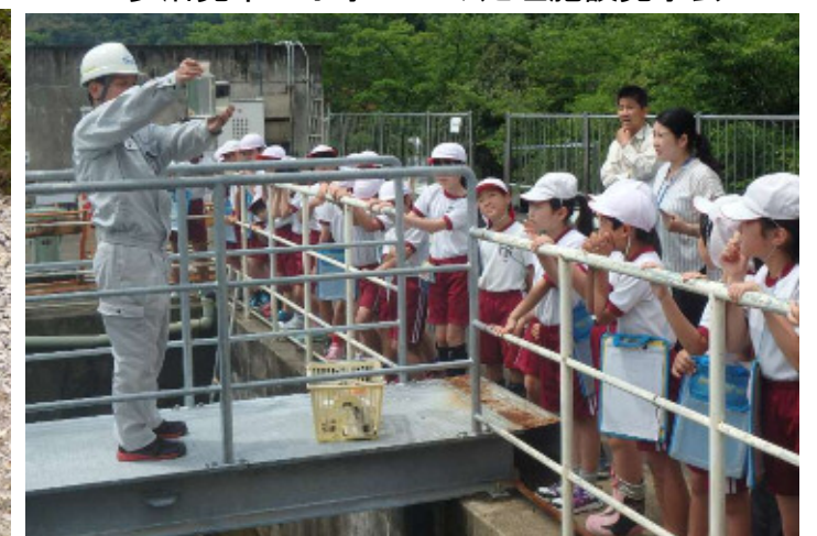
愛岐処分場(浸出水処理施設)
