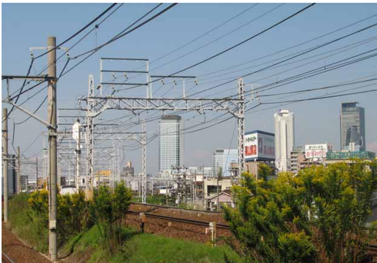
写真 2-6-11 №10 地点（尾頭橋駅、撮影日：平成 20 年 10 月 17 日）
