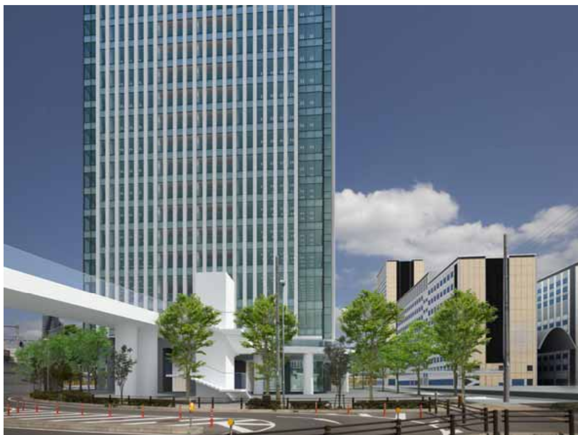
写真 2-6-2 №1 地点（ささしまライブ駅前、撮影日：平成 20 年 9 月 9 日）
