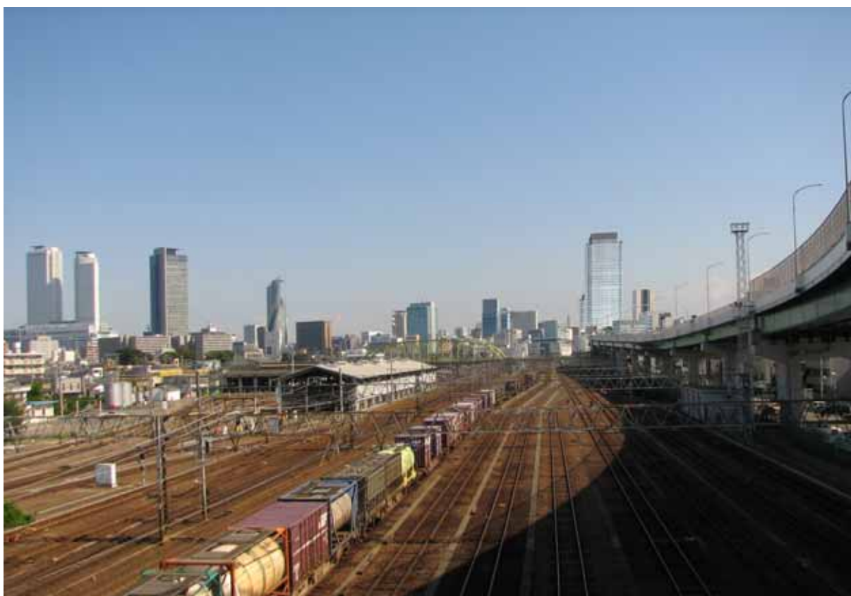
写真 2-6-7 №6 地点（黄金橋、撮影日：平成 20 年 10 月 17 日）
