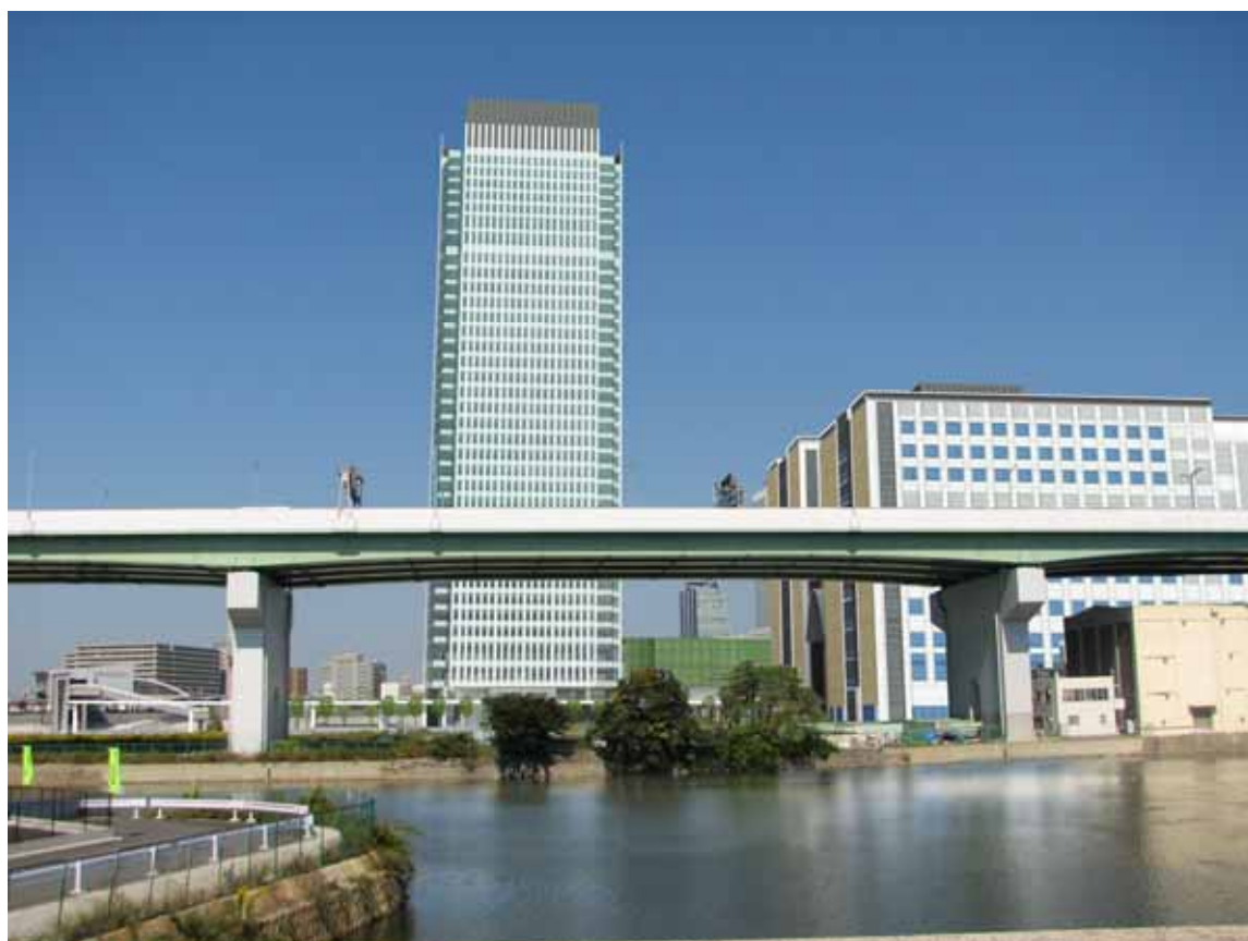
写真 2-6-6 №5 地点（運河橋、撮影日：平成 20 年 10 月 17 日）
