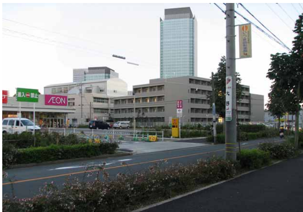
写真 2-6-4 №3 地点（名古屋セントラル病院前、撮影日：平成 20 年 10 月 15 日）
