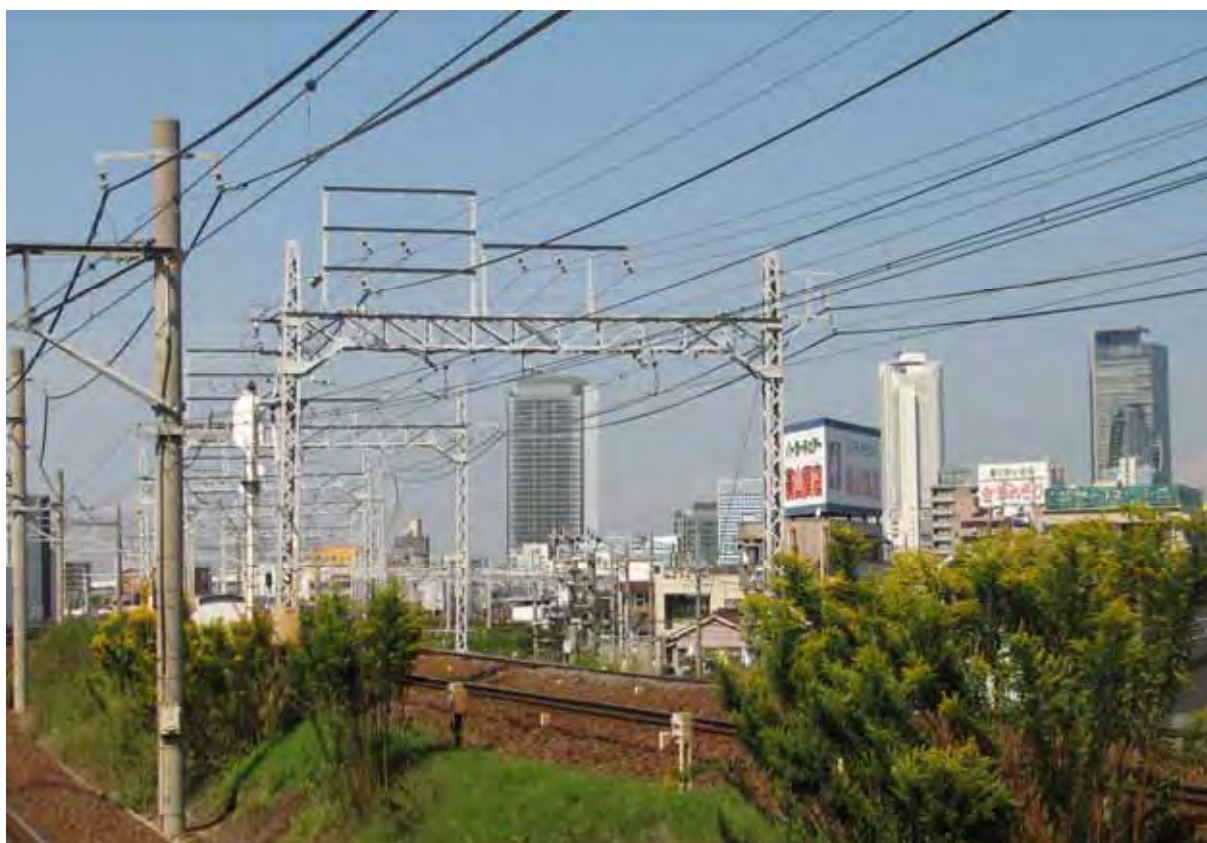
写真 2-6-11 №10 地点（尾頭橋駅、撮影日：平成 20 年 10 月 17 日）
