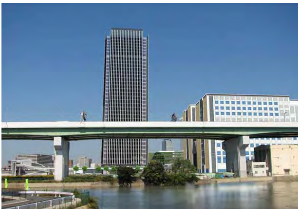
写真 2-6-6 № 5 地点（運河橋、撮影日：平成 20 年 10 月 17 日）
