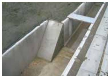
小動物が側溝に落ちてでも這い上げられるように設置された斜路(スロープ)
