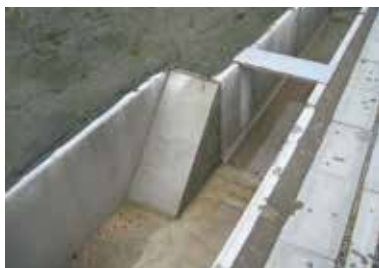
小動物が側溝に落ちてでも這い上がれるように設置された斜路（スロープ）
