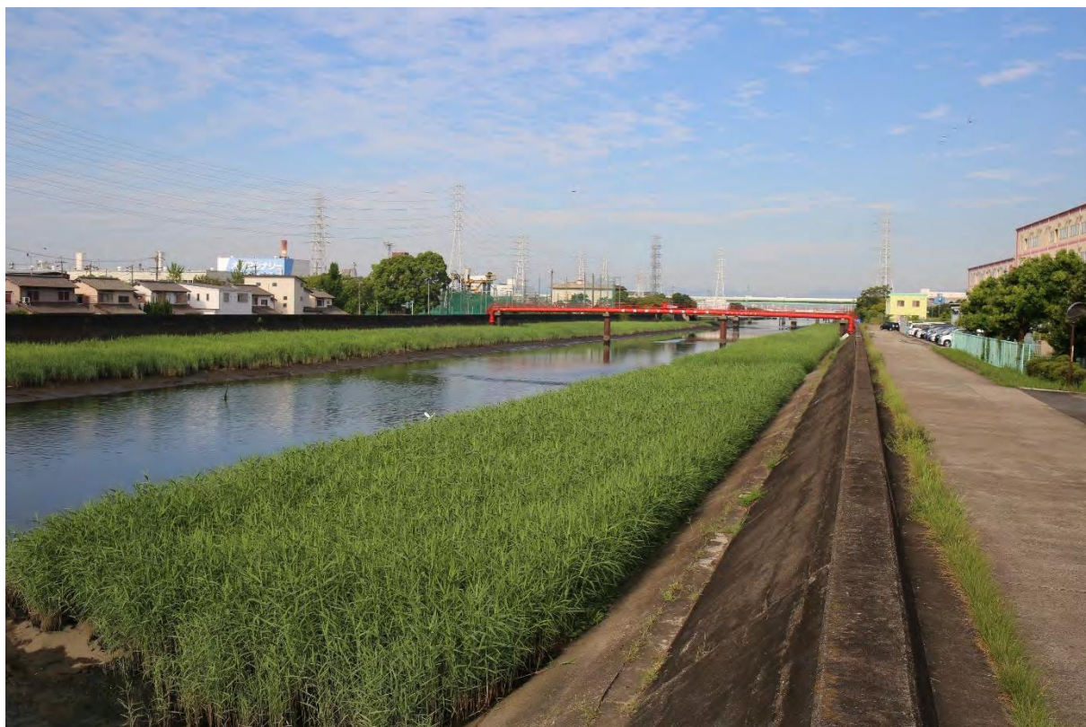
図 2-3-2 現在の大江川の様子（大江ポンプ所付近から下流側を望む）
