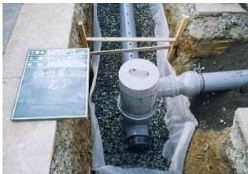
■ 雨水浸透ますを設置する様子
