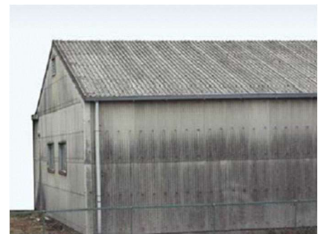
■石綿含有成形板（スレート屋根）
