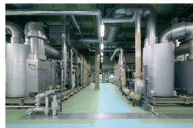
都市ガスを燃料に発電し、同時に発生する熱を活用するガスコージェネレーション
