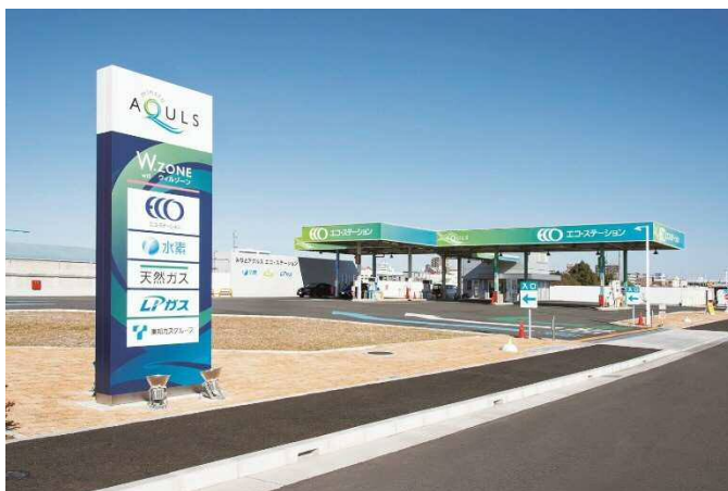
図 水素、圧縮天然ガス（CNG）、LPG の3種類のエネルギーを充填する施設として日本初となる「みなとアクルス エコ・ステーション」（2016 年、みなとアクルス エコ・ステーション（東邦ガス株式会社））
