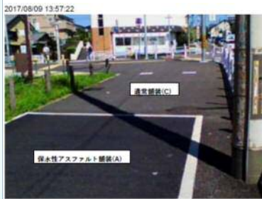
図 湧水（地下漏水）の活用事例（名古屋市昭和区川名駅）（2017～2020 年度、湧水を活用したヒートアイランド現象緩和の実証実験（名古屋市））
